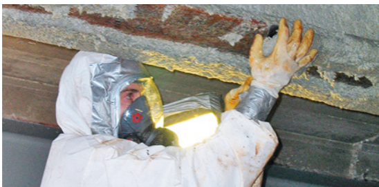
Lavori di bonifica
